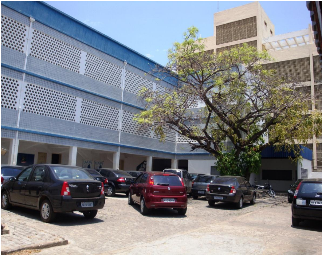
Foto 01: Prédio do CEAD/UFPI
