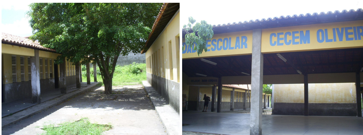
Foto 1 – Pátio lateral externo e pátio coberto interno da escola Cecem Oliveira, da rede estadual de ensino. Teresina – Piauí.
