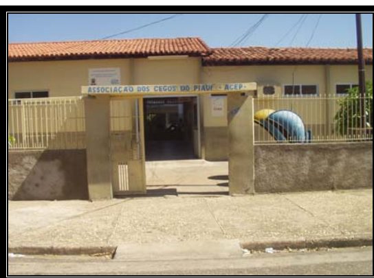
Foto nº 26 – Prédio da ACEP (PI) depois da reforma Fonte: acervo da autora, 2006
