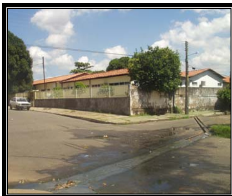
Foto nº 01 – Esgoto transbordando Fonte: acervo da autora, 2006
