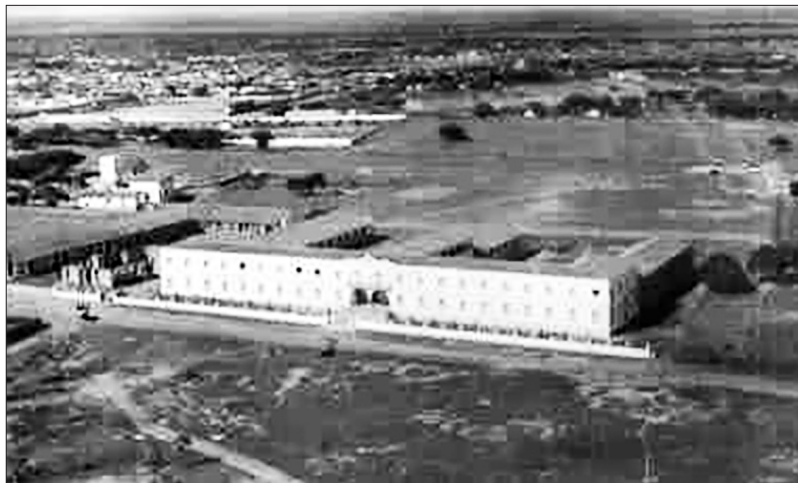
Figura 1 – Prédio do CDSL (1956)
