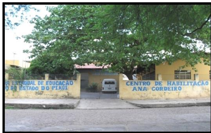
Figura nº 02 – Prédio da antiga Escola Especial Ana Cordeiro.
