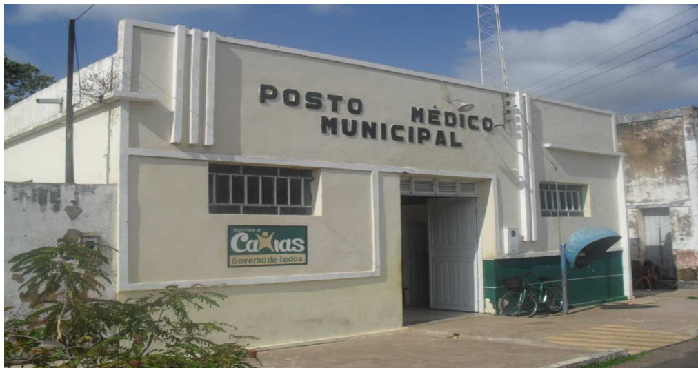
Figura n. 1: Posto Médico Pública Municipal do Bairro Ponte. Fonte: Arquivo da Pesquisadora.
