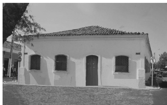
Foto 9 – Prédio do Hotel Carneiro, fachada lateral que ficava defronte à Praça Coronel Ozório, Parnaíba/PI.
