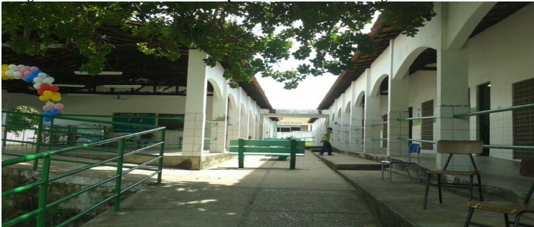
Fotografia 3: Fachada da Escola Municipal Ministro Rubem Ludwig
