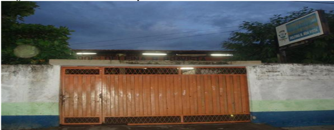
Fotografia 5: Fachada da Escola Municipal Delfina Borralho Boa Vista
