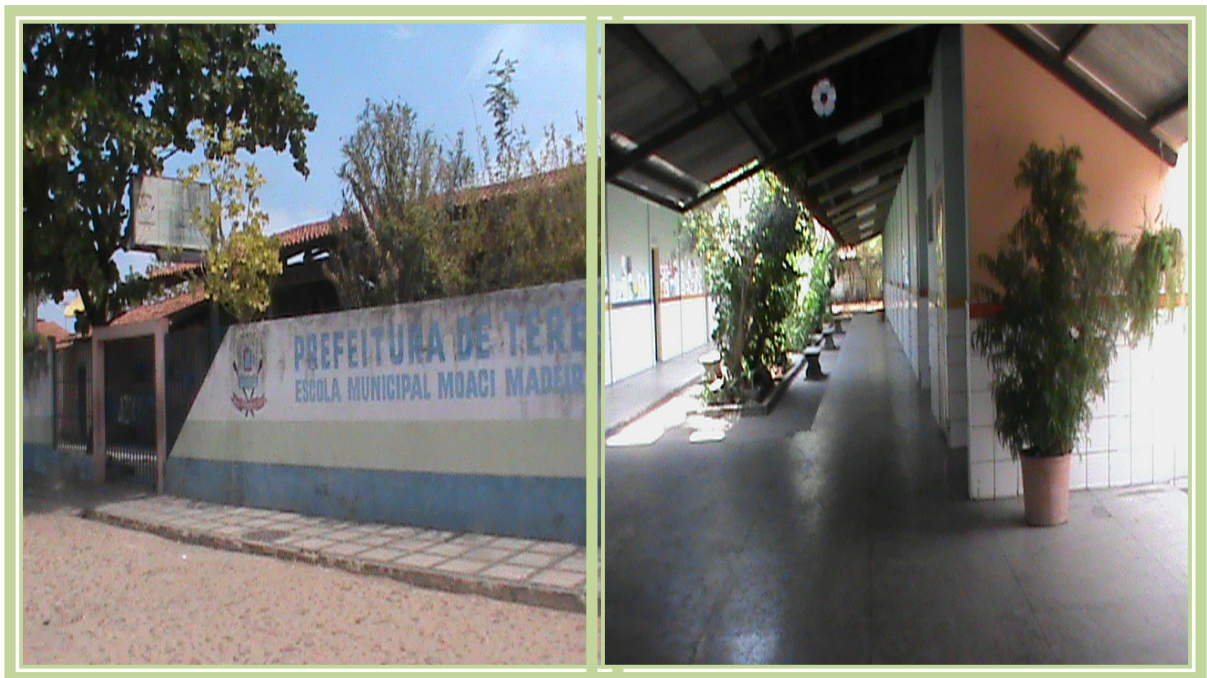
Figura 02 - E. M. “Moaci Madeira Campos” - Entrada principal e corredor que dá acesso às salas de aula
