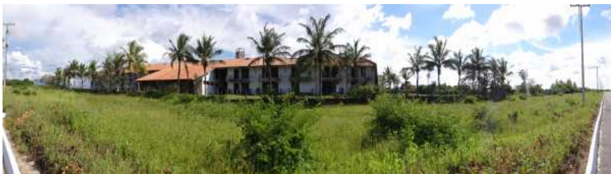
Figura 30 – Estrutura abandonada entre Parnaíba e Luís Correia
