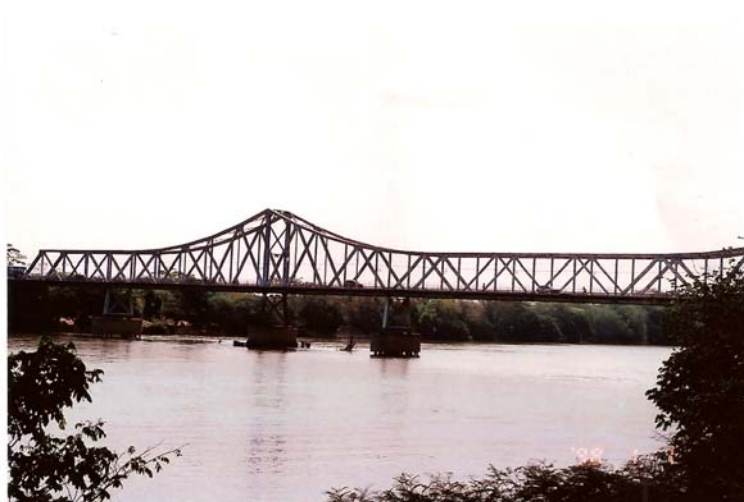
Figura 29: Ponte João Luis Ferreira - Ponte Metálica Fonte: Sousa (2008)
