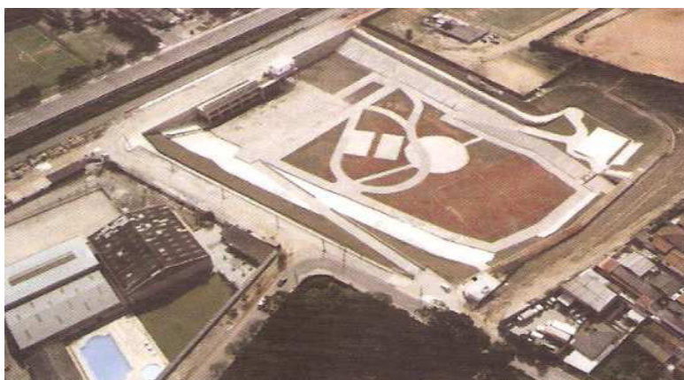
Figura 2.14: Bacia de detenção Fonte: Canholi, 2005
