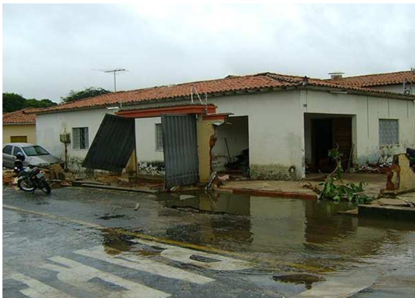
Figura 5.5: Prejuízos causados pela chuva em casa da zona leste da cidade de Teresina. Fonte: Foto de Patrício Lima (2009)
