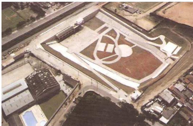
Figura 6.4: Bacia de detenção em Santo André, SP Fonte: Canholi, 2005
