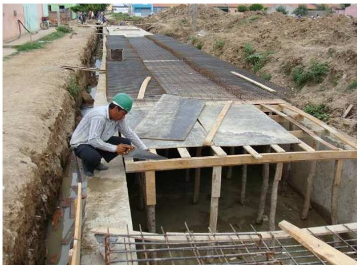
Figura 2.9: Execução de canal de macrodrenagem Fonte: Rodrigues (2010)
