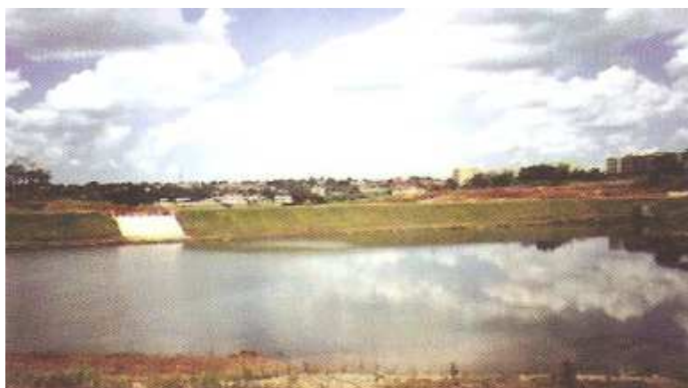
Figura 2.13: Bacia de retenção Fonte: Canholi, 2005
