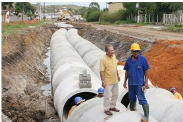
Figura 2.8: Tubulação para macrodrenagem Fonte: Guaratinguetá (2008)
